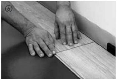
Die weiteren Elemente der ersten Reihe sind an den Kopfenden von oben in die vorherige Diele einzuklicken. Durch kurzen Druck auf den Querstoß rastet das Element im angrenzenden Element ein. Hierbei ist auf eine exakte Flucht der Elemente zu achten. Das letzte Element der ersten Reihe wird unter Berücksichtigung des Dehungsabstandes von 10-15 mm zur Wand zugeschnitten und eingefügt.
