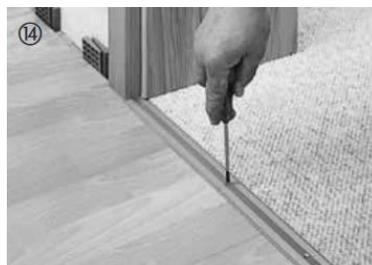
In der Schiene ist ein Dehnungsabstand von ca. 5 mm einzuhalten. Grundsätzlich müssen Holz Türstöcke in Bodenelementdicke mit einer Feinsäge abgeschnitten werden, damit der Laminatboden eine Dehnungsmöglichkeit hat. Nach der Verlegung unbedingt die Abstandskeile entfernen. Sockelleisten werden an der Wand befestigt.
