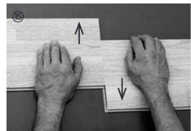
Zum Demontieren können die Elemente parallel auseinandergeschoben werden.
