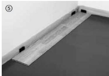
In der rechten Raumecke beginnend, werden die Elemente mit der Federseite zur Wand verlegt und mit Abstandskleinen fixiert (Dehungsabstand zur Wand 10-15 mm).
