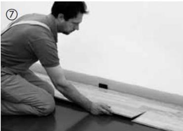
Mit dem Reststück in der ersten Reihe wird in der nächsten Reihe wieder begonnen (stirnseitiger Versatz von mind. 50 cm). Dadurch wird der Verschnitt erheblich reduziert. Die weitere Verlegung erfolgt elementweise. Dazu werden die Elemente zuerst längsseitig mit leichtem Druck in die Verbindung eingedreht.
