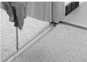
Zur Einhaltung des Dehnungsabstandes muss bei Türübergängen stets ein geeignetes 2-teiliges Profilsystem eingesetzt werden. Dies gilt auch, wenn im angrenzenden Raum der gleiche Boden verlegt werden soll. In diesem Fall ist für die Einhaltung der Dehnungsfuge eine Übergangsprofil einzusetzen.
