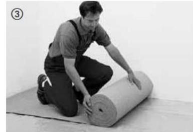
Zur Trittschalldämmung und zu Ausgleich kleiner Unebenheiten wird eine geeignete Dämmunterlage bündig ausgerollt.
