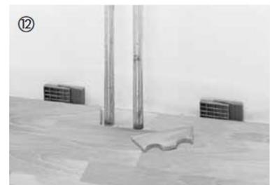
Für aus dem Boden herausragende Heizungsrohre werden in die Elemente Öffnungen (Größe abhängig vom jeweiligen Heizungsrohr und unter Berücksichtigung des erforderlichen Dehnungsabstandes) gebohrt oder gesägt.
